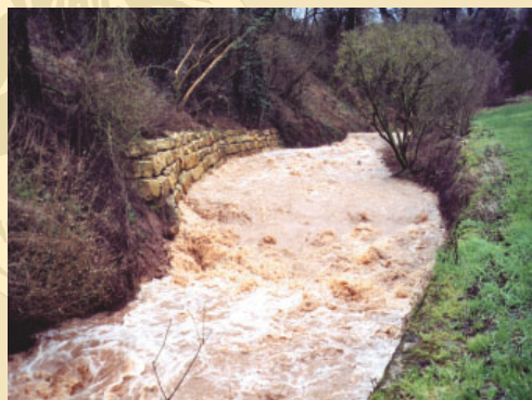
Des berges consolidées
